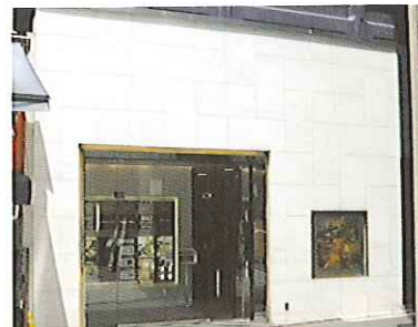
外壁 大理石鏡面仕上げ 改修、張り替え時に塗布施工
