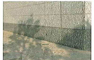
立ち上げ箇所及び床面のバサノロに使用
