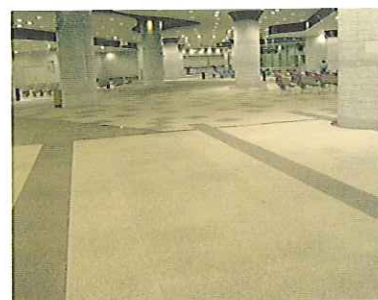
内装床(JRA関係施設) 御影石バーナー仕上げ面 新築時に施工
