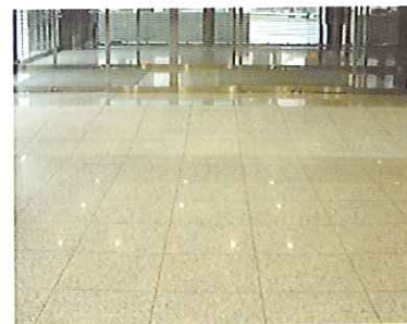
内装床(国際赤坂ビル) 御影石 研磨面・バーナー面
