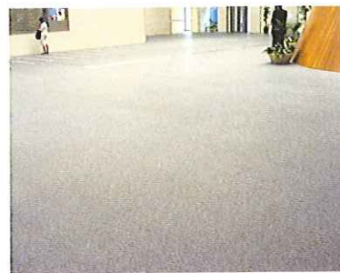
内装床(堂島アバンザ) 御影石バーナー仕上げ面 イシクリーンシリーズで洗浄後、塗布施工
