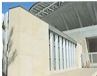
屋外塙(新潟スタジアム) 御影石小叩き仕上げ 新築時に塗布施工
