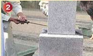
2 目地部分にクサビやバールを差し込み目地部を少し広げます。目地にコーキングのこを入れて接着部分を切っていきます。
