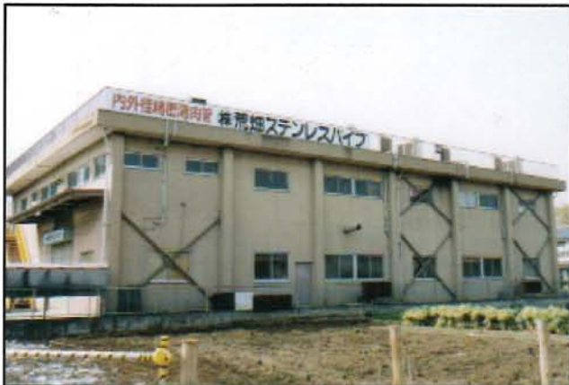
本社・所沢工場
